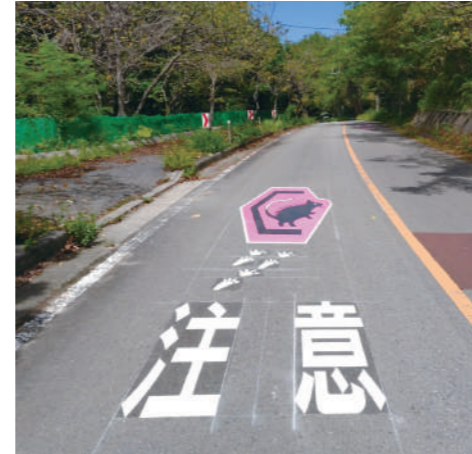
小動物注意喚起（ケナガネズミ）標示設置工事
