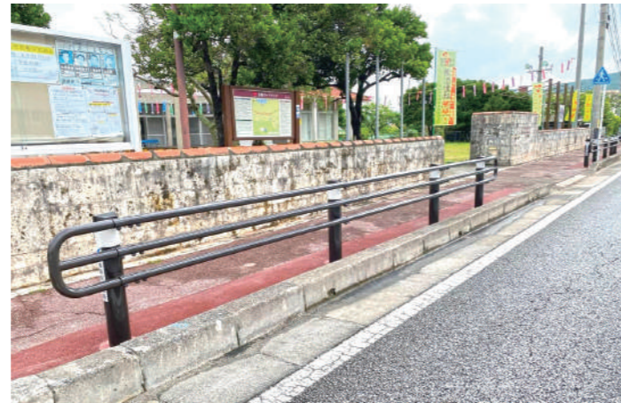
車両用防護柵設置工事
