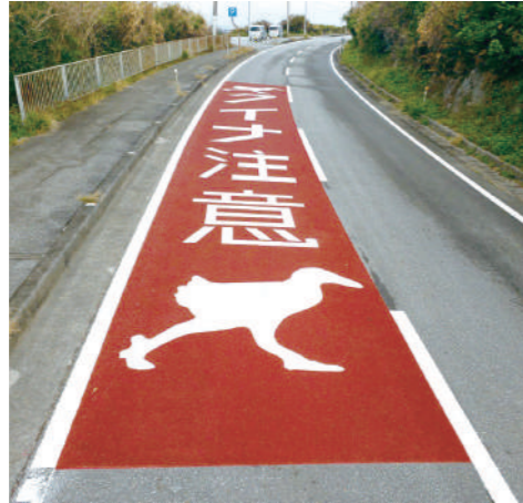
道路標示設置工事
