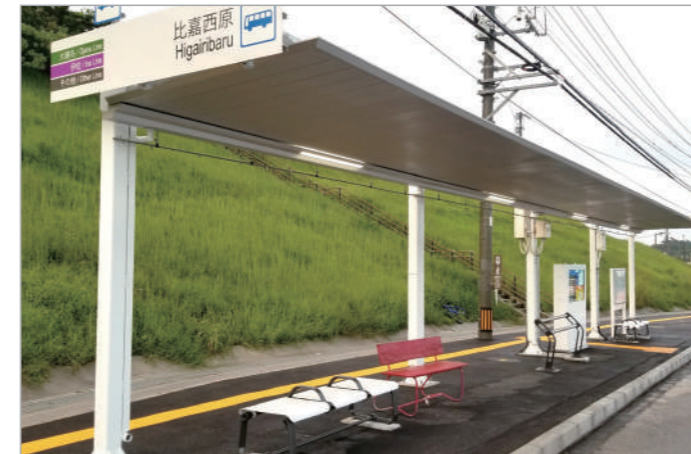
ハイグレードバス停上屋設置工事
