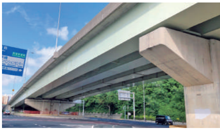
高架橋塗装工事
