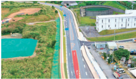
ゆずり車線設置工事
