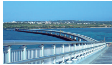
高欄設置工事
