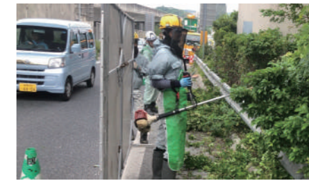
道路除草作業
