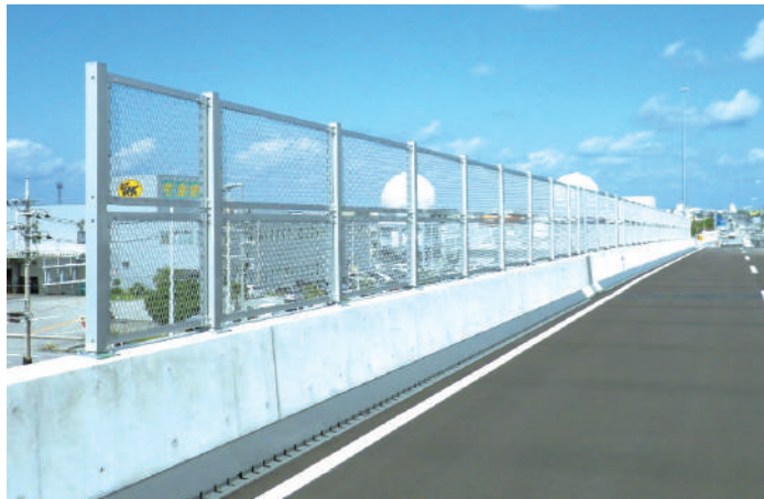
落下物防止柵設置工事
