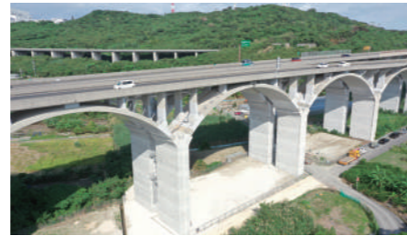
橋梁耐震補強工事
