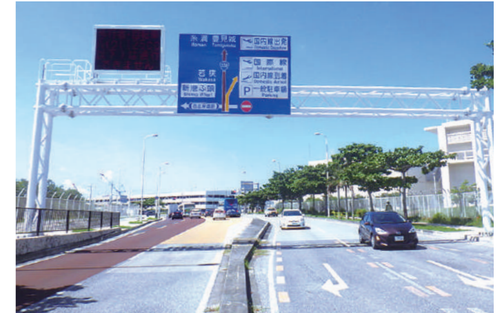
道路標識設置工事（門型）
