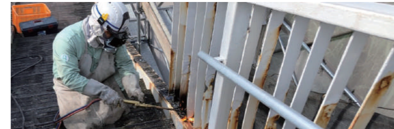
佐敷歩道橋修繕工事
