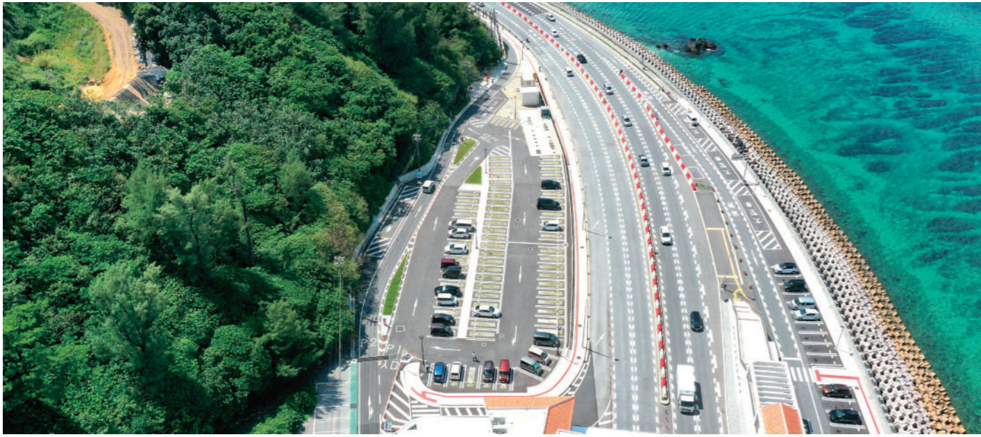
道の駐車場整備工事
