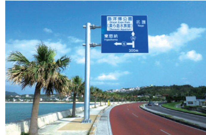
道路標識設置工事（F型）
