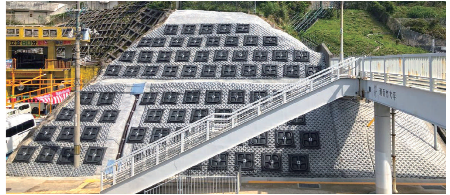
法面修繕工事
