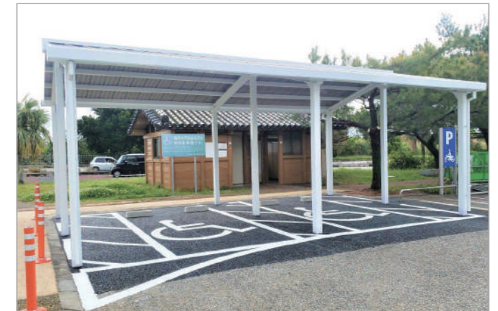
身障者用上屋駐車場設置工事
