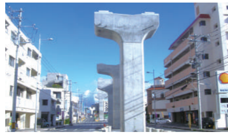
都市モノレール下部工事
