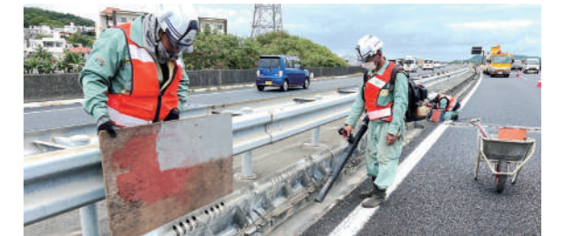
高規格道路側溝清掃作業
