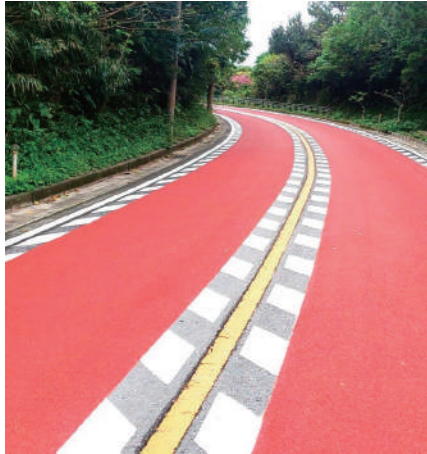
薄層カラー舗装設置工事
