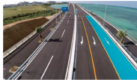
道路改良工事
