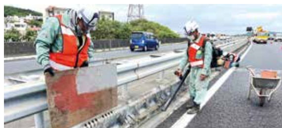
高規格道路側溝清掃作業
