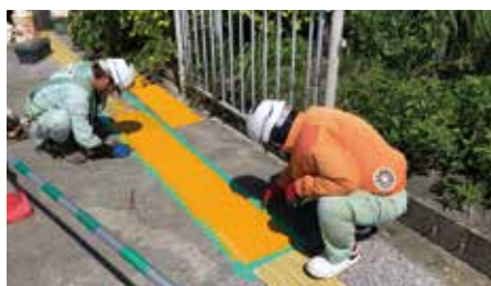
視覚障害者誘導標示シート設置工事
