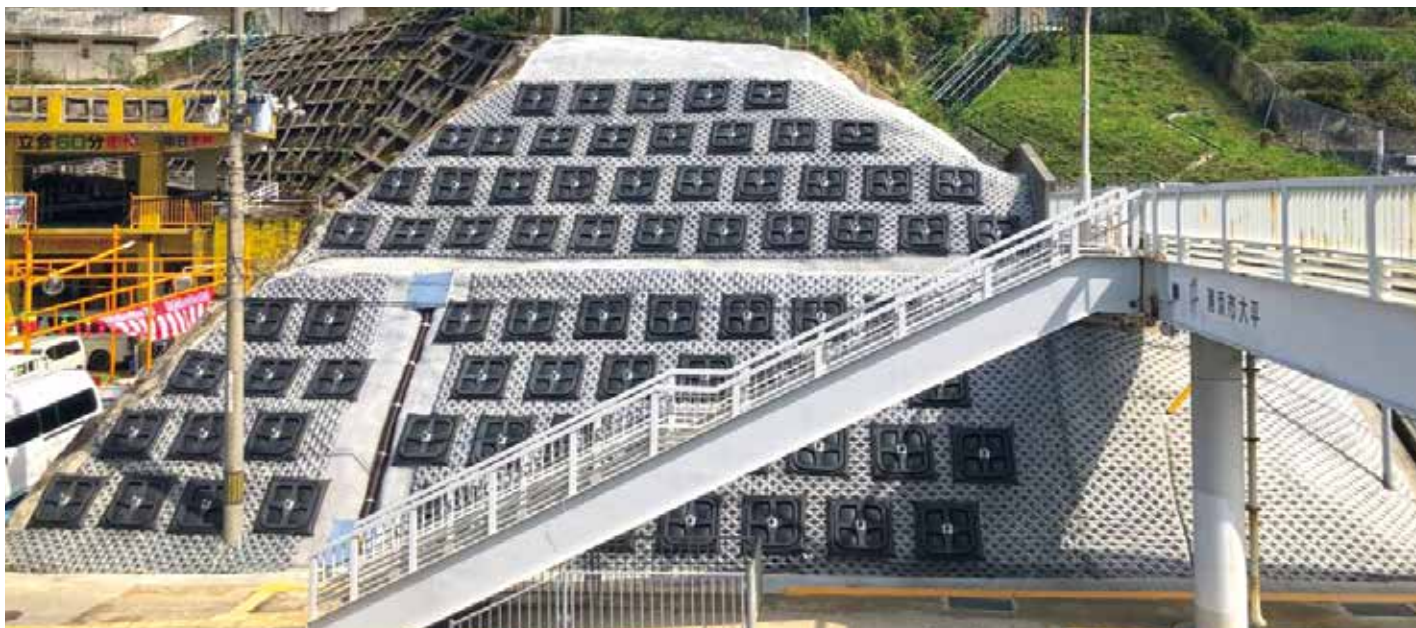
法面修繕工事
