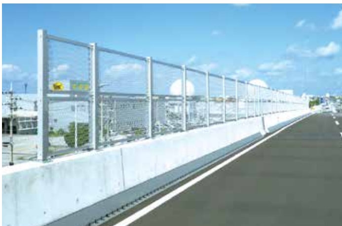
落下物防止柵設置工事
