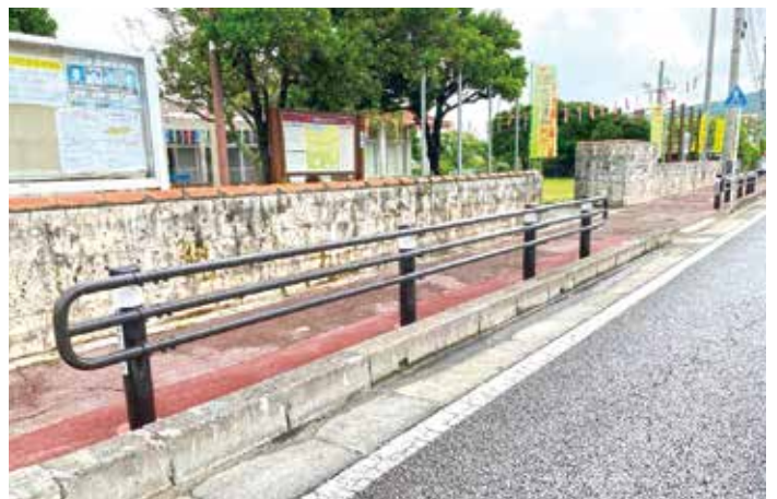
車両用防護柵設置工事
