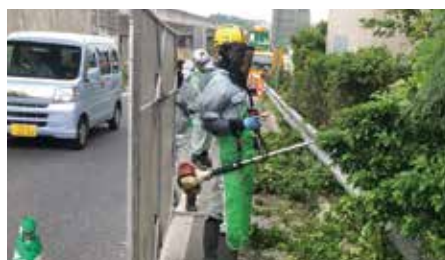
道路除草作業
