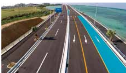
道路改良工事
