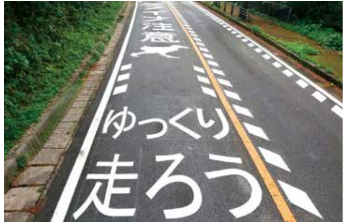
道路標示設置工事
