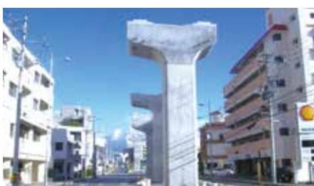
都市モノレール下部工事
