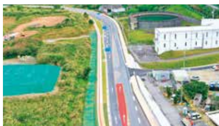
ゆずり車線設置工事
