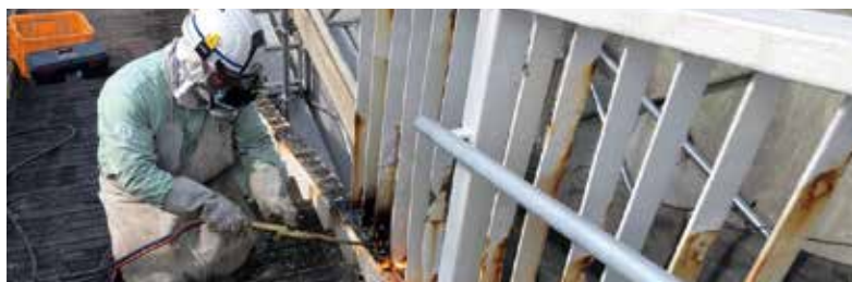
佐敷歩道橋修繕工事
