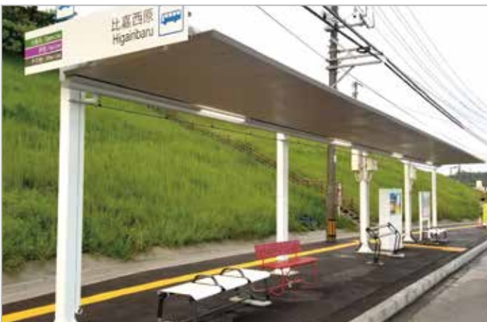
ハイグレードバス停上屋設置工事
