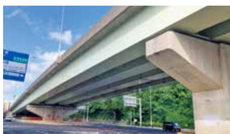
高架橋塗装工事
