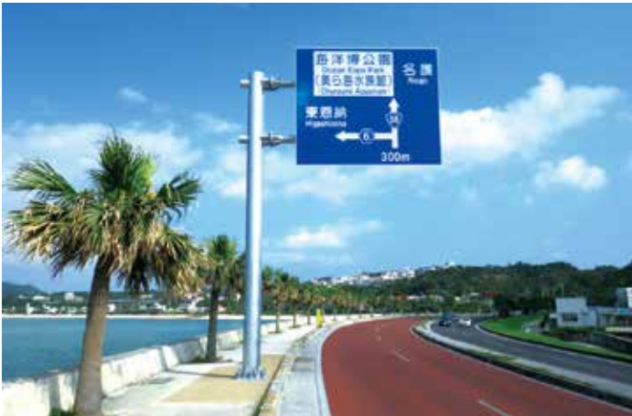
道路標識設置工事 (F型)
