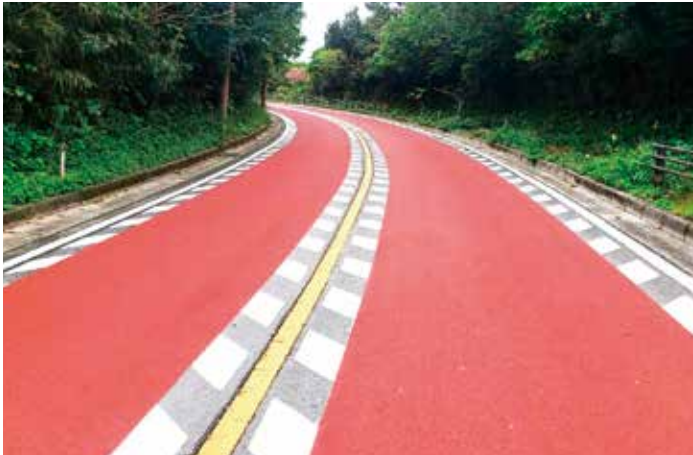
薄層カラー舗装設置工事
