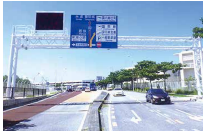
道路標識設置工事 (門型)
