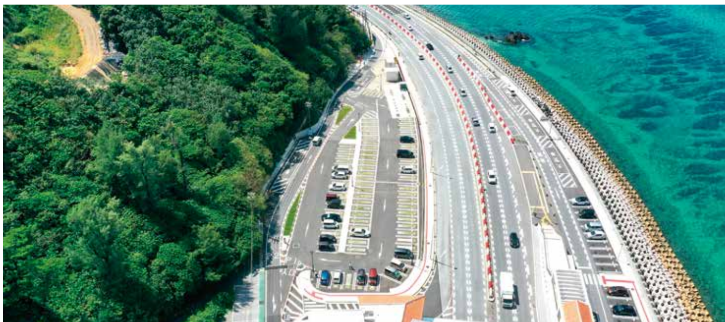
道の駐車準備工事
