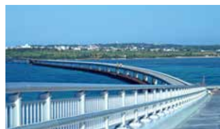
高欄設置工事
