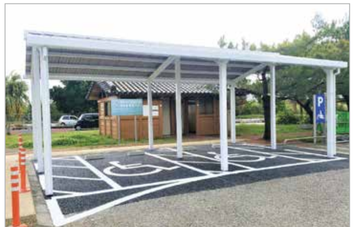
身障者用上屋駐車場設置工事
